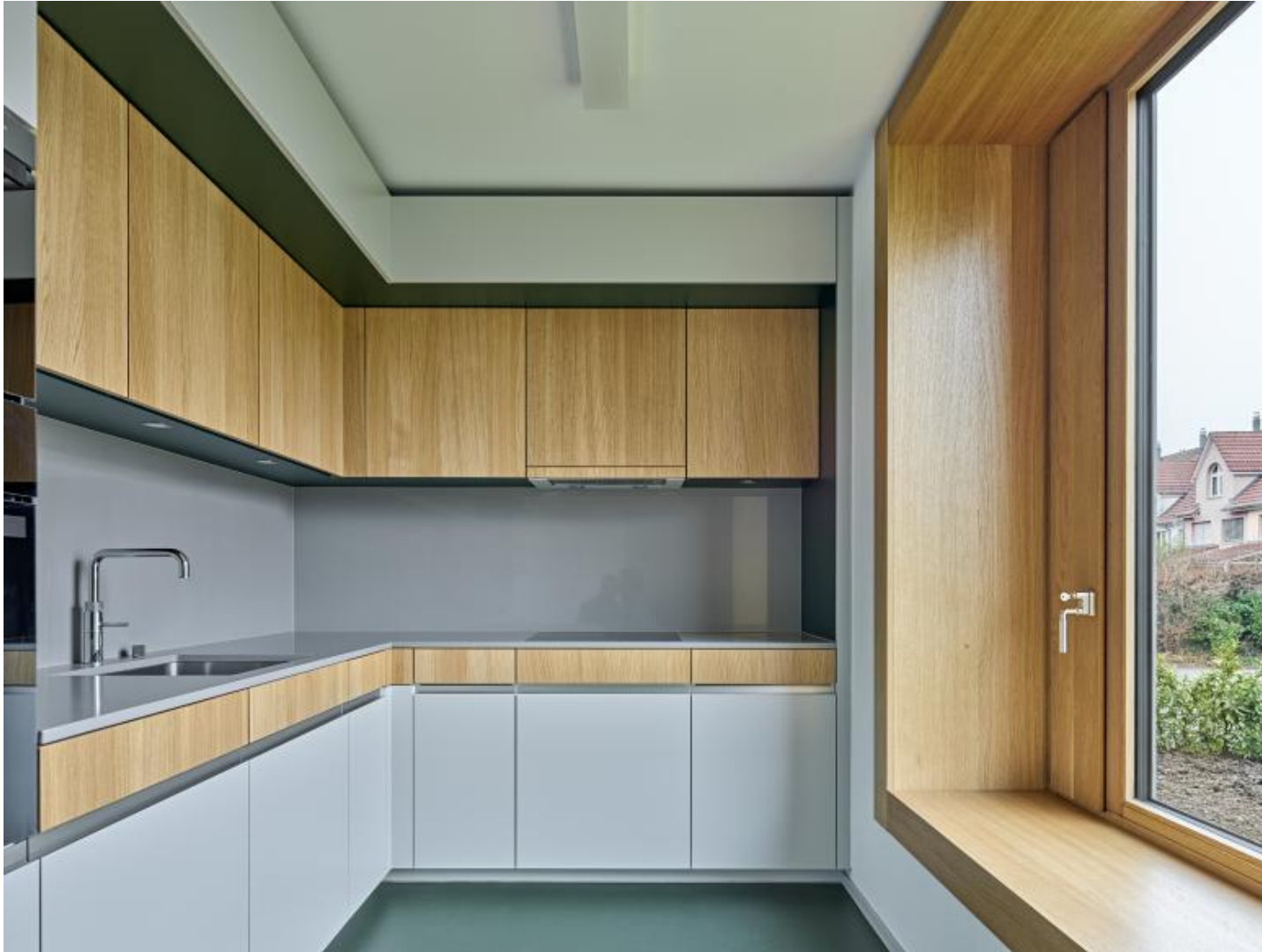
In den sanierten Küchen dienen Kastenfenster als Sitzgelegenheit, die Küchenzeilen wurden in den Essraum erweitert. (Foto: Roger Frei)
