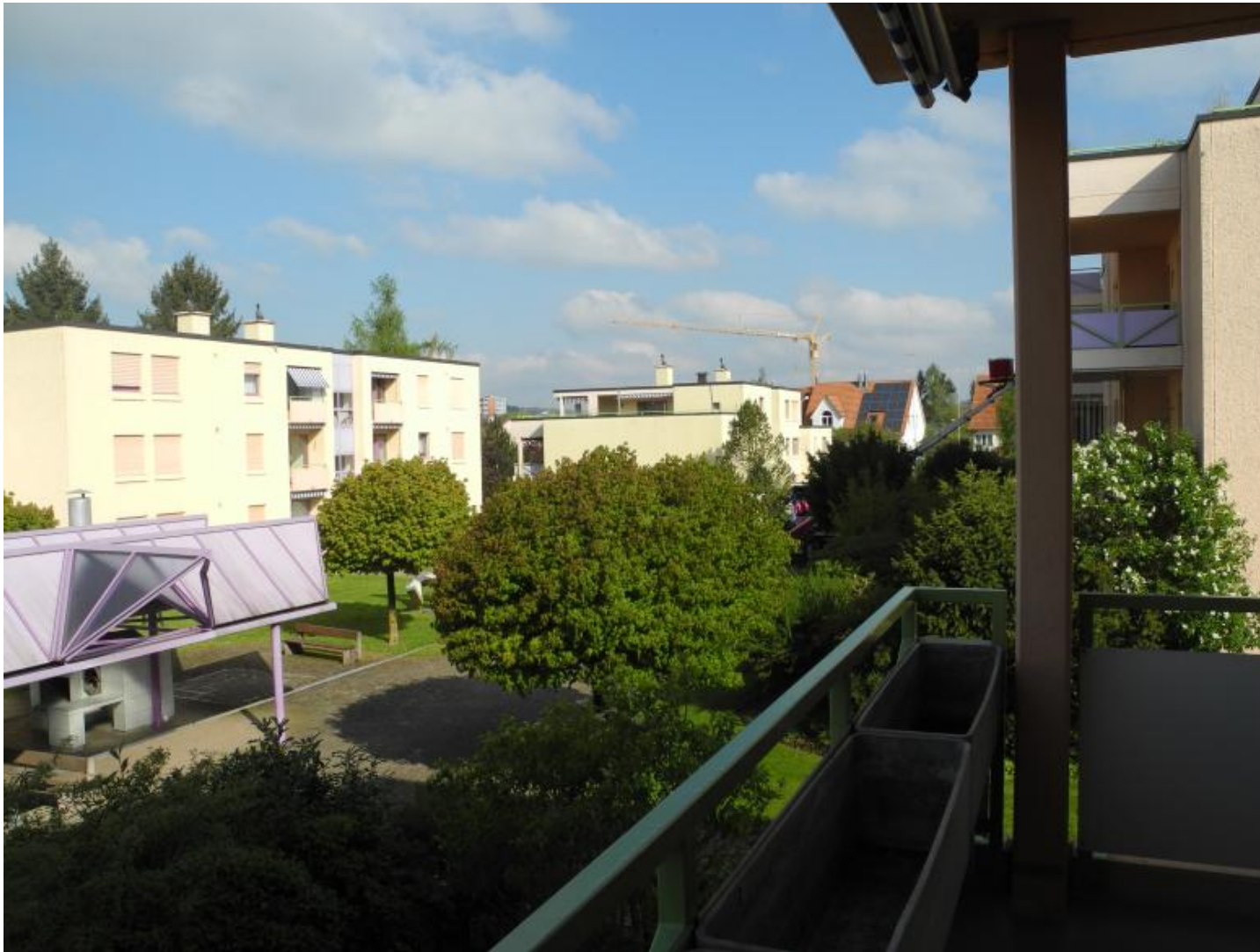
Die Siedlung aus den 1980er-Jahren vor der Sanierung (Foto: Züst Gübeli Gambetti)
